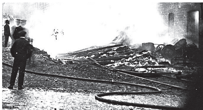
Bild 1. Den förödande branden ödelade de flesta byggnaderna utom ladugården.
