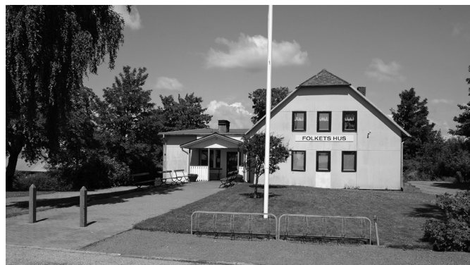
2011. Inga stora förändringar 40 år senare. Huset har fått en skylt med "Folkets hus" och en ombyggd entré utan trappor.
