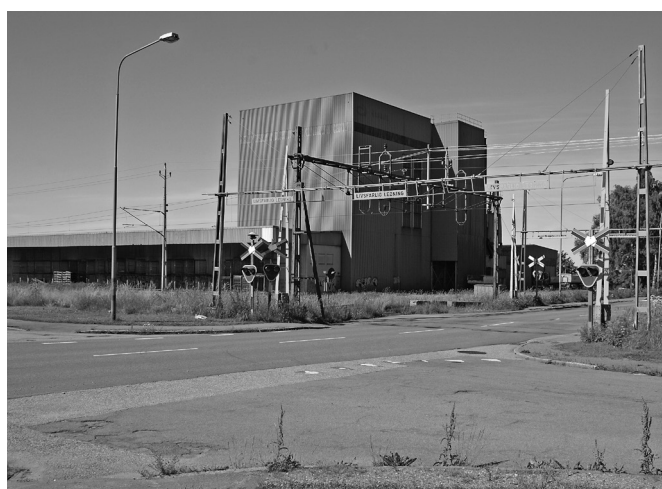
2011. Allt har sin tid. Utsädesanläggningen har sen några stängts och står oanvänd. Fyra år senare rivs hela anläggningen.
