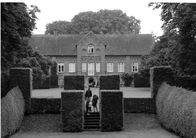
Bild 2. Axel Tönnesen Viffert byggde upp och namngav Axelvolds gods.
