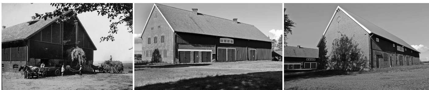
Bild 21, 22 o 23. Nybyggda ekonomibygnader efter Utsädesbolagets övertagande. Till vänster nya kostallet från 1913 med hissloge, i mitten västra längan byggd och påbyggd 1937 och 1943 samt östra längan byggd 1936.
