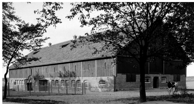
Bild 17. Ett nytt toppmodernt kostall stod färdigt 1913. Det hade hiss för att ta in hela lass av hö och halm på loftet.
