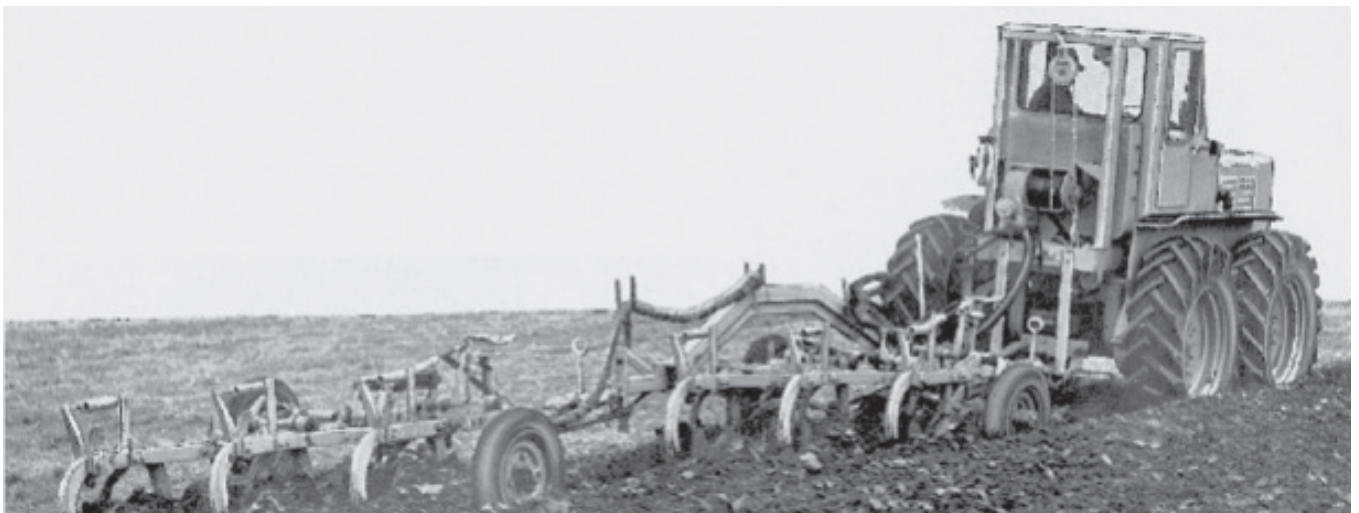
Stortraktorn Svedala Elefant plöjer med två seriekopplade 3-skäriga Överumplogar på Barsebäck, ett hektar i timmen. AB Åbjörn Andersson hade traktorn kvar några år i sortimentet men det blev ingen framgång.
