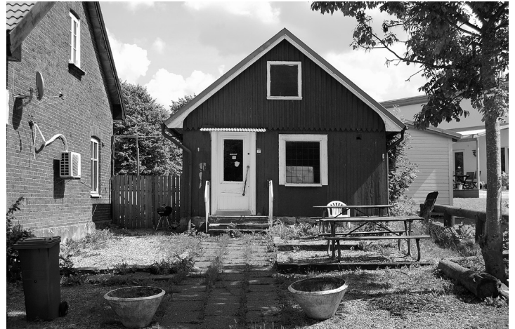
2011. Bageriet och godisförsäljningen har upphört. Senare förfaller husen en del och en brand skadar det gamla bageriet. Idag är det nyrestaurerat och prydligt igen.
